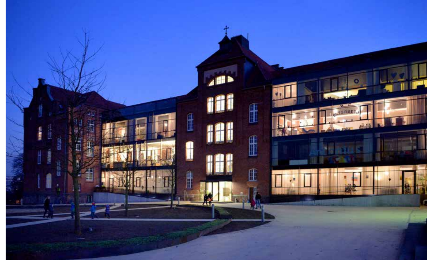
Auch der Bestand erzeugt erhebliche Kosten: Um mehr Selbstbestimmung und Privatheit im Wohnen zu erzielen, waren umfassende Umbaumaßnahmen nötig
